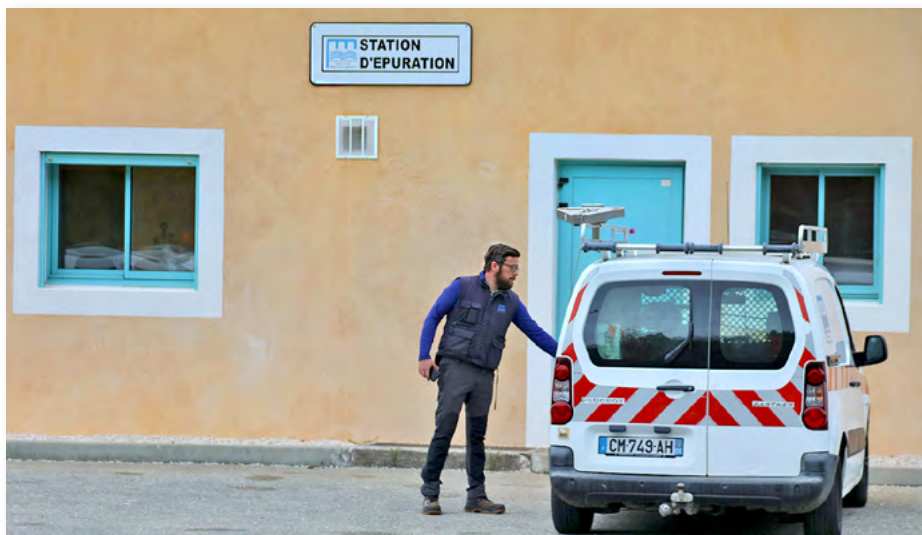
Romain Bailly à la station d'épuration des Canebiers
