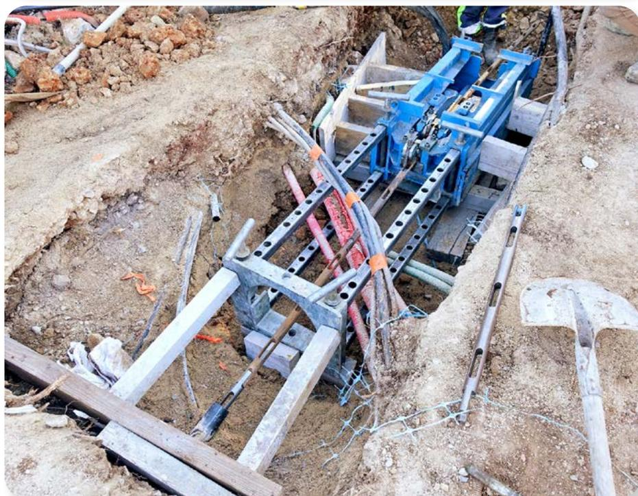
La canalisation neuve est ensuite tractée en lieu et place du réseau existant, qui est découpé au passage. L'opération était délicate, mais elle s'est bien déroulée, grâce à une préparation soignée et une étroite collaboration avec la société SUBTERRA, en charge de la substitution. Ce procédé permet de tirer plus de 100 mètres linéaires de canalisation par jour.
