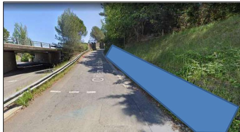
*Illustration indicative de la zone où sera opéré l'élargissement, nécessitant la mise en œuvre de mesures de soutènement et de talutage pour traiter la topographie.*
