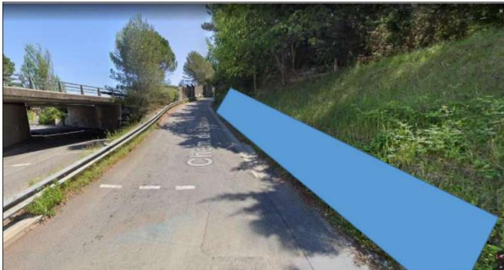
Illustration indicative de la zone où sera opéré l'élargissement, nécessitant la mise en œuvre de mesures de soutènement et de talutage pour traiter la topographie.
