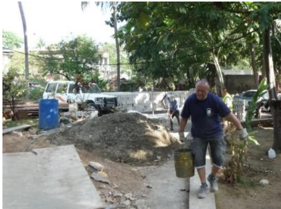
Photo – Gilbert et Jean-Christophe sur la coulée du béton des fondations
