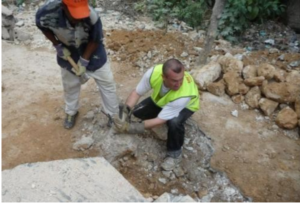
Photo – Burin improvisé avec un ½ arbre de roue : attention les doigts !
