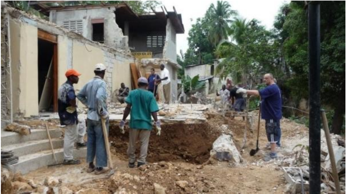
Photo – Travaux de fouilles : Gilbert
