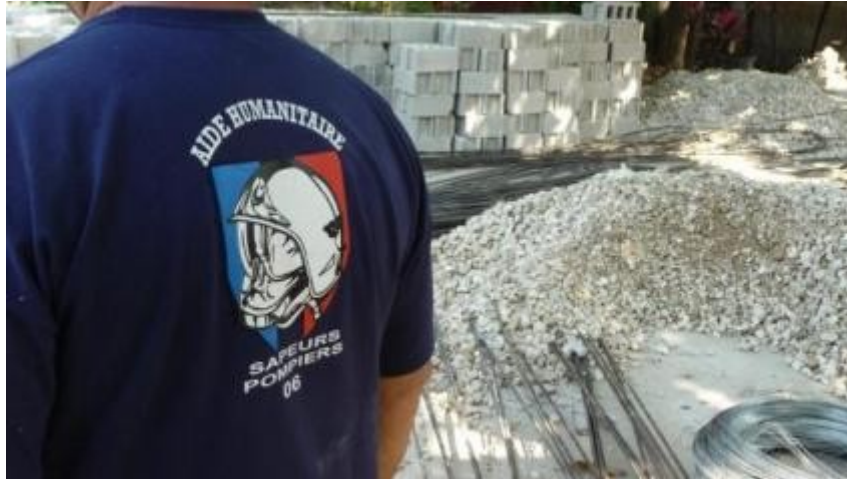
Photo - Ensemble des matériaux achetés par l'association et livrés sur le chantier
