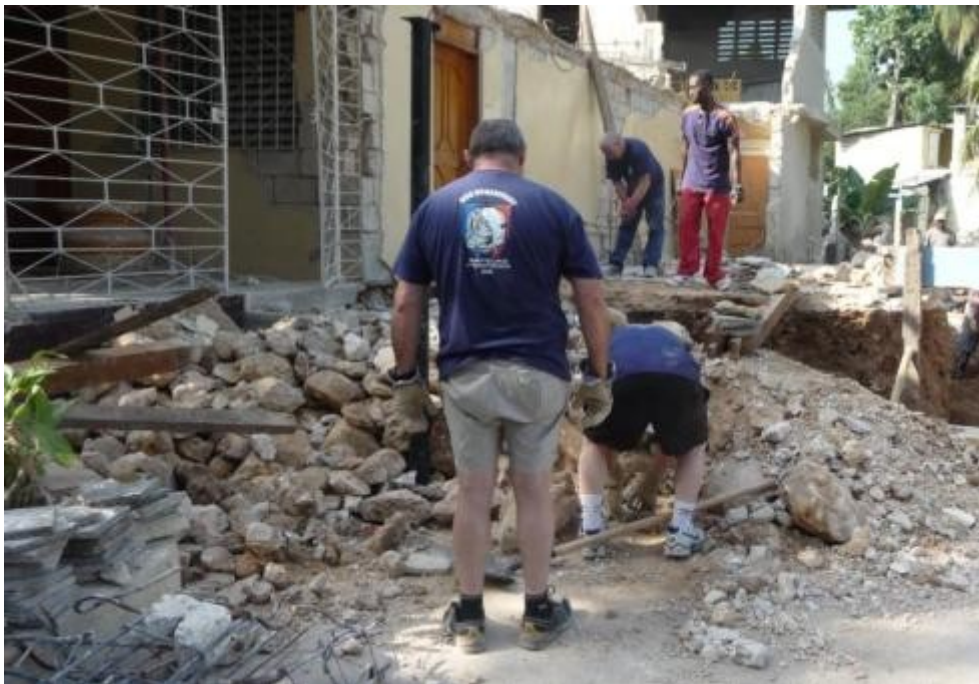
Photo – Laurent, Daniel et Georges coffrage de l'autre aile du bâtiment
